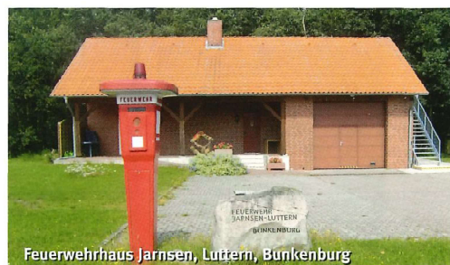
Feuerwehrhaus Jarnsen, Lüttern, Bunkenburg
